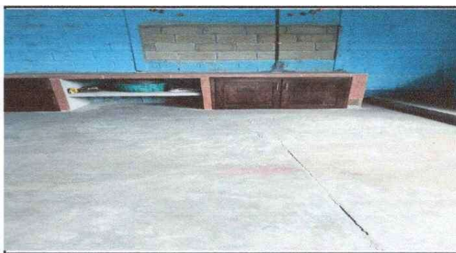
Foto 6: Sustitución de torta de cemento de 42 2 por piso ceramico antideslizante
