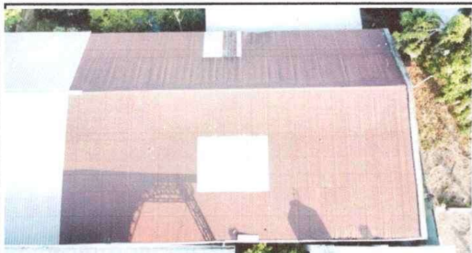
Foto 1: Se instalará 280.60 2 de cambio de techado en la cocina y dos salones de clases.
