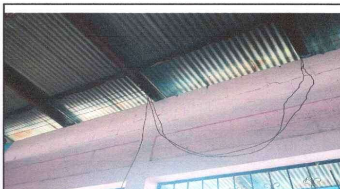
Foto 4: Se instalará 200 metros lineales de energía en los salones que se cambiara estructura y techo.
