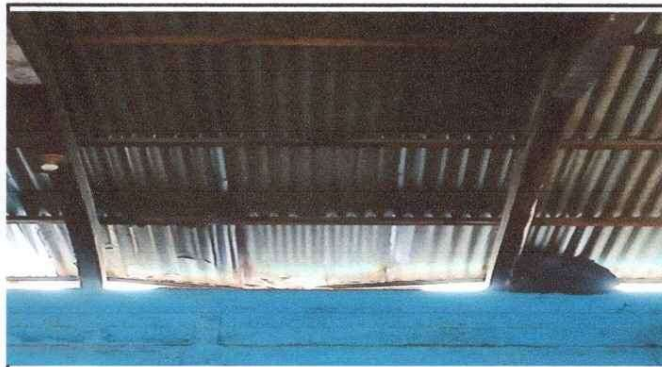
Foto 2: Se instalará 280.60 2 de cambio de techado en la cocina y dos salones de clases.
